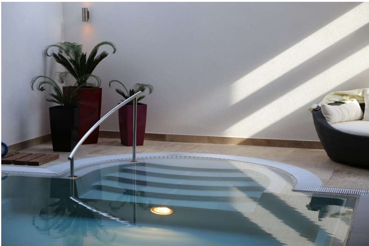
Sonnenlicht und Unterwasserscheinwerfer im Schwimmbad – Wasserspiegel = Fußbodenniveau durch Überlaufbecken
